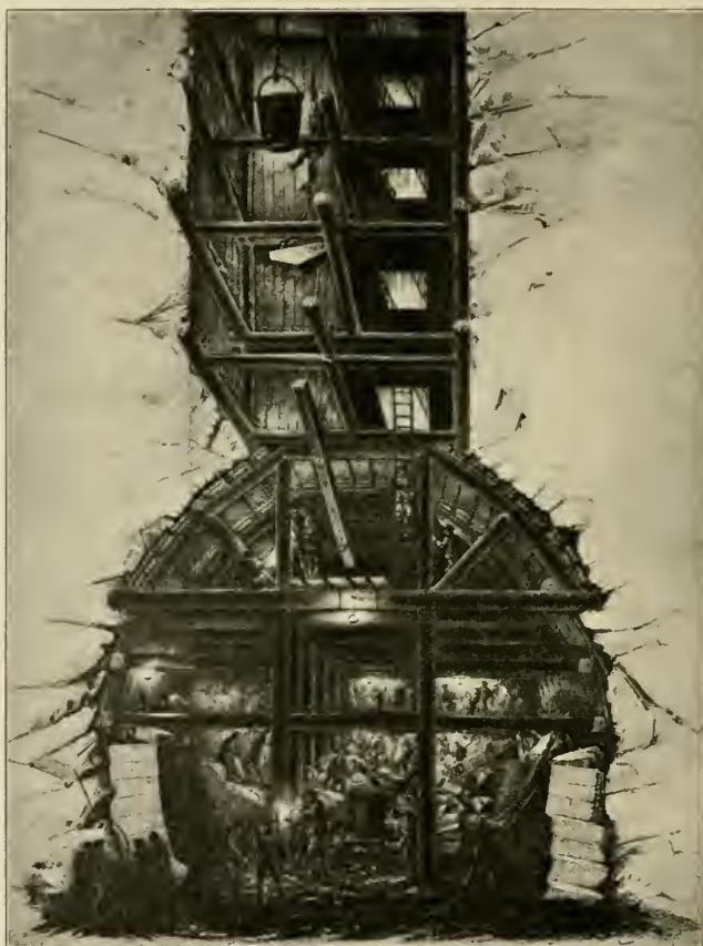
Abb. 90. Bau des alten Pressburger Tunnels. [Nach einem Original im Privatbesitze des Ingenieurs J. Deutsch, Pressburg.]
